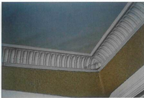
Mynd 8. Rakaskemmdir í veggjum (a) og frágangur kverka (b) í íbúðarhúsi.
