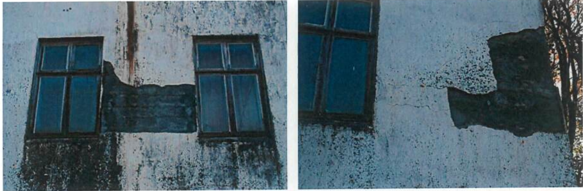
Mynd 5. Skemmdir á pússningu norðurhliðar íbúðarhúss.
