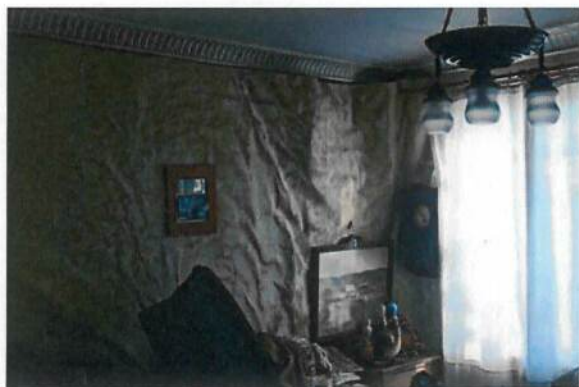
Mynd 8. Rakaskemmdir í veggjum (a) og frágangur kverka (b) í íbúðarhúsi.
