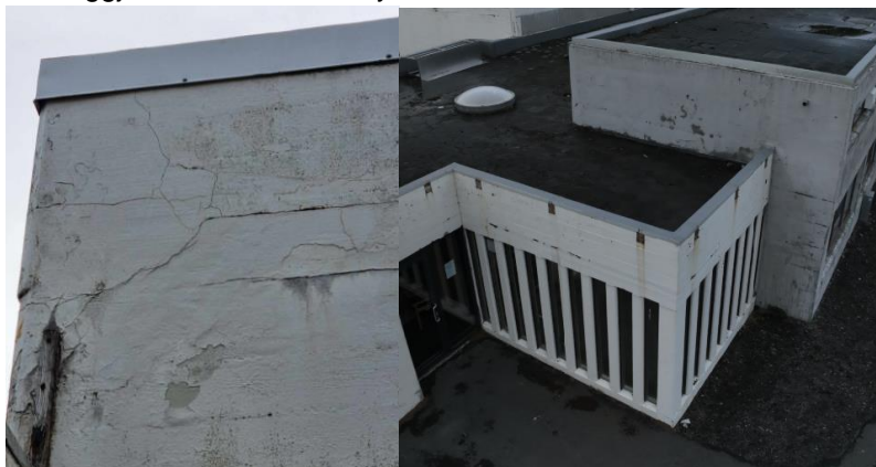
Mynd 11 – Ásýnd á veggum Suðurbyggingar.
