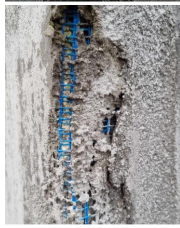
Mynd 12 – Myndir af afleitum frágangi Verktaka 1 við uppsetningu múrkerfis.
