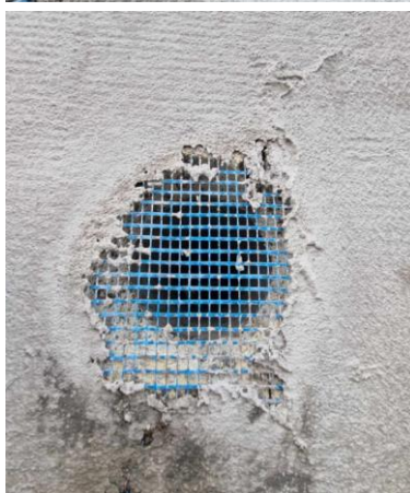
Mynd 12 – Myndir af afleitum frágangi Verktaka 1 við uppsetningu múrkerfis.
